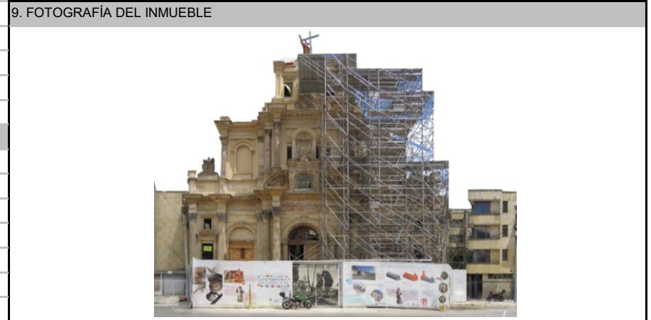
Fuente: Equipo Fotografía PEMP Patrimonio Inmueble
